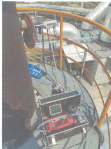
锅炉排气筒出口 01#
